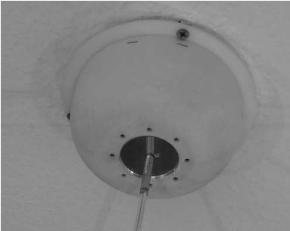
Abb. 4 Fertig montierte Verbindungsplatte mit Trafoglocke und Kabel
